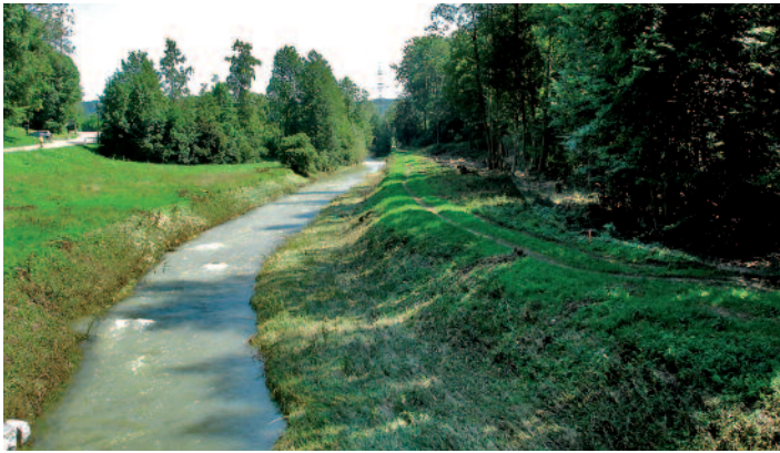
Reppisch kurz vor der Revitalisierung. La rivière Reppisch peu avant sa revitalisation.
