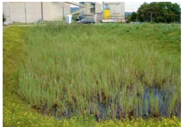
Becken Ost der SABA Ristet August 2009.
