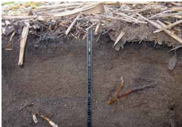
Profil durch Sandfilter mit Sedimentauflage und Farbwechsel im Sand bei rund zwanzig Zentimeter Tiefe. Der Farbwechsel zeigt an, wie weit sich die Schadstofffront im Filter nach unten verlagert hat.
