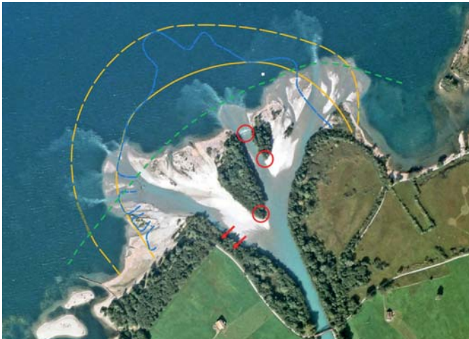
Bild 4. Entwicklung des Reussdeltas 2008. Uferangriff 2012 (rote Pfeile). Rückbau der harten Massnahmen (rote Kreise). Ursprüngliche Begrenzung der Schutzzone (grüne Linie). Delta im Langzeitversuch an der VAW (blaue Linie). Vermutete Interventionslinie (gelb gestrichelt), Hauptdelta (gelbe Linie) bei Erreichen der Interventionslinie durch ein Subdelta (Aufnahme Flotron AG, Meiringen).
