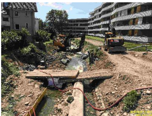
Wasserhaltung für Bau Sohle mit Schwellen
