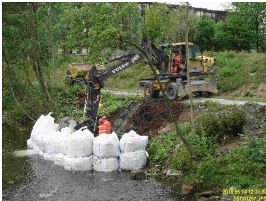
Wasserhaltung für Bachzugang
