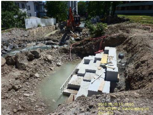
Wasserhaltung für Bachzugang
