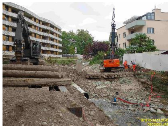
Bau und Erhöhung Ufermauer
