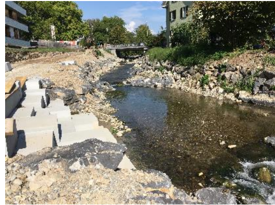
Böschungssicherungen mit Blockwurf
