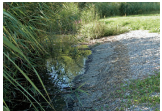
Abb. 1 SABA Chrebsbachknie: Kiesfilter im Ufer des Sedimentationsteiches, nach zehn Betriebsjahren und 2-maligem Ersatz der obersten 20 cm, August 2006. (ILU)
