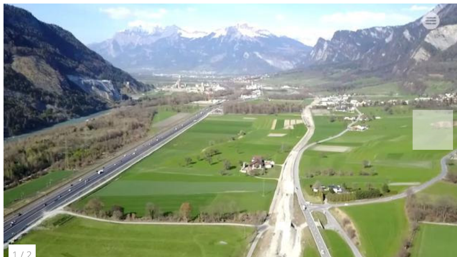
Das Material der alten Spur wurde für den Bau der neuen Strasse gebraucht. Screenshot
